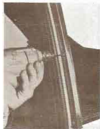
Extracción mediante una taladradora portátil de los remaches que sujetan la moldura sobre el montante central
