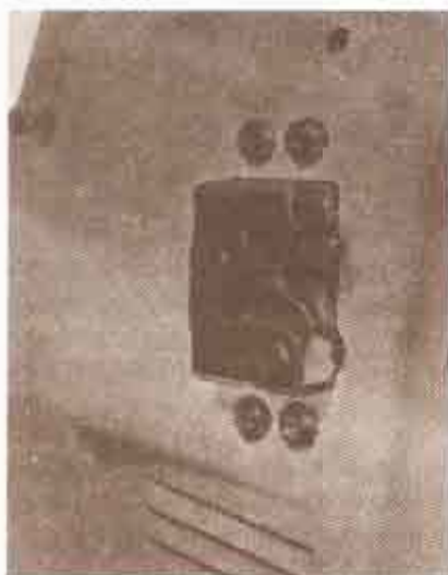
Detalle de fijación cerradura a la puerta
